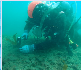
■ダイバーによる設置作業
