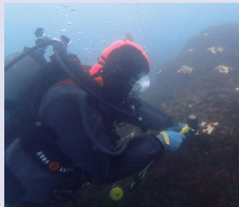
■ダイバーによる設置作業
