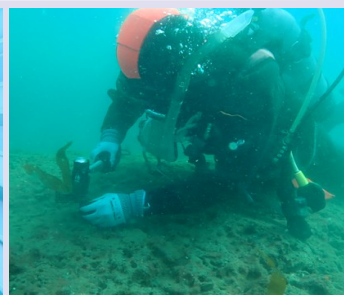
■ダイバーによる設置作業
