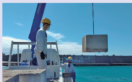
■着生礁としてコンクリート塊の投入
